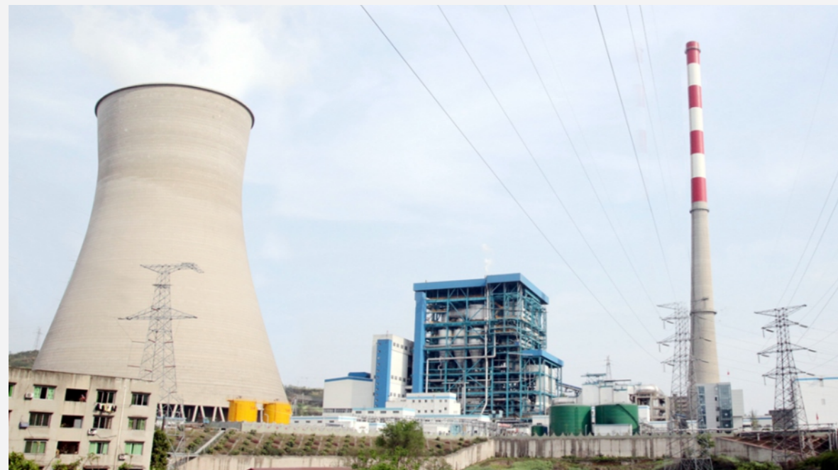
东方电气研制的世界首台600兆瓦超临界循环流化床锅炉在四川白马电厂投运
