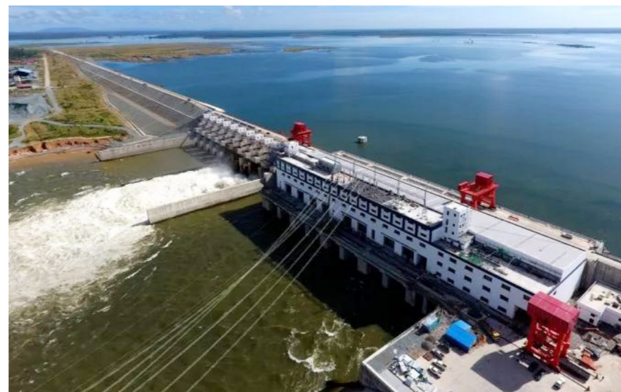
柬埔寨桑河二级水电站
