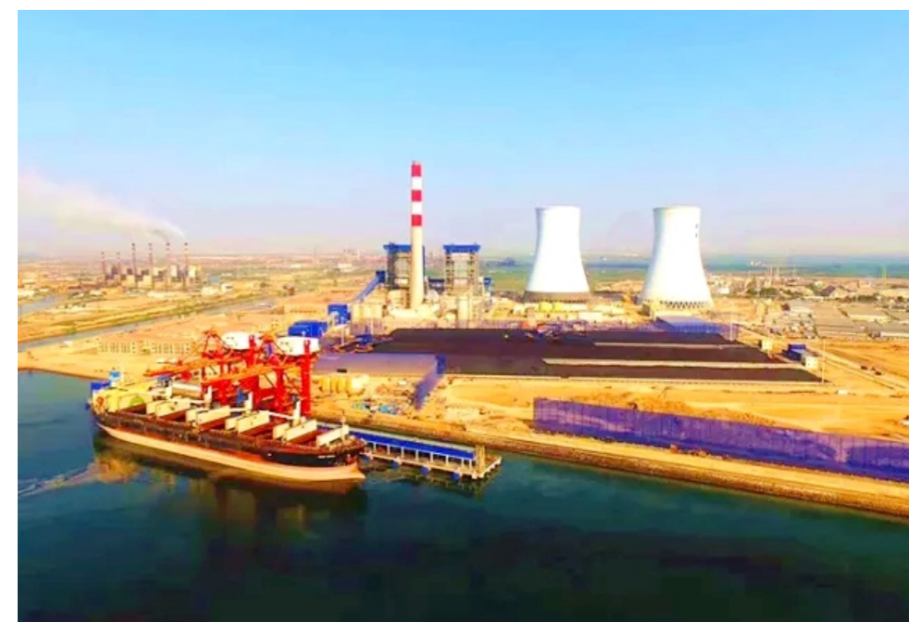
巴基斯坦卡西姆港燃煤电站
